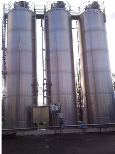
Les silos sont au nombre de 5 : 3 silos de farine (30t), 2 silos (55t). Ces silos stockent de la farine.
